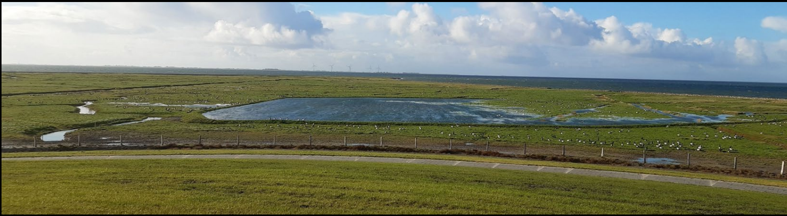
Maßnahme 2 – Rohrkoog : Blick von der Norderwarft nach Westen
