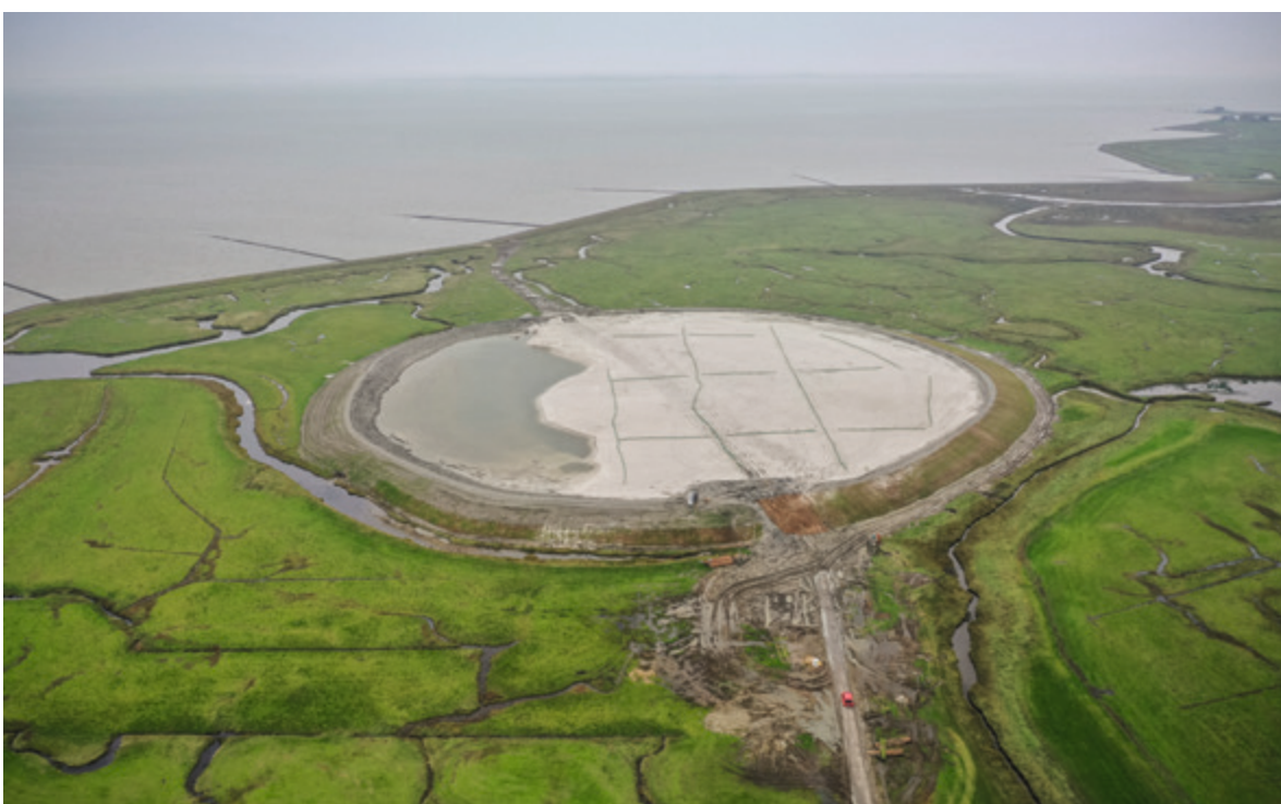
Bauabschluss im Herbst 2019
