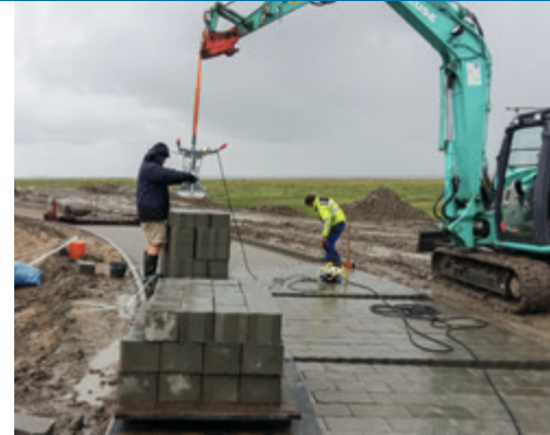
Setzen der Steine für den Treibselabfahrweg
