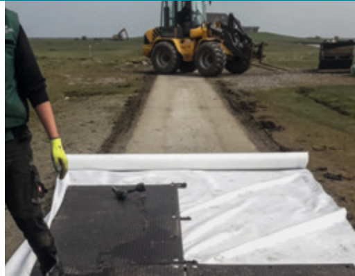
Schützende Befestigung der Straße
