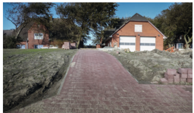
Die ersten Auffahrten sind gepflastert.
