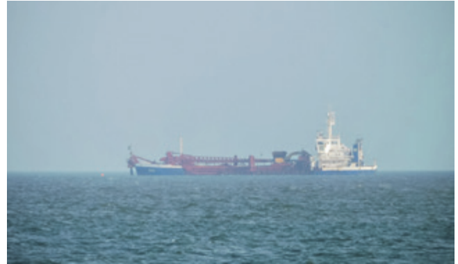
Einsatz des Hopperbaggers
