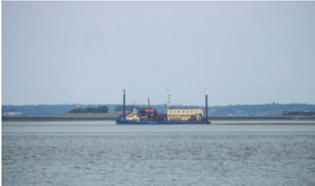
Zu Spülbeginn erfolgt die Einrichtung der Boosterstation in der Süderaue
