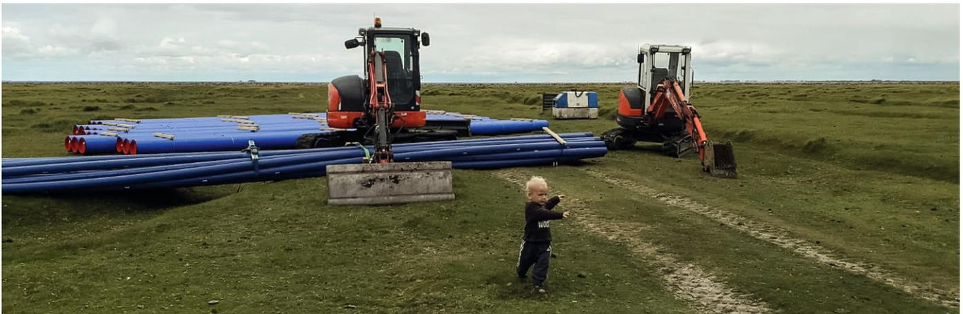
Verlegung der Wasser- und Stromleitungen aus dem alten Warftkörper
