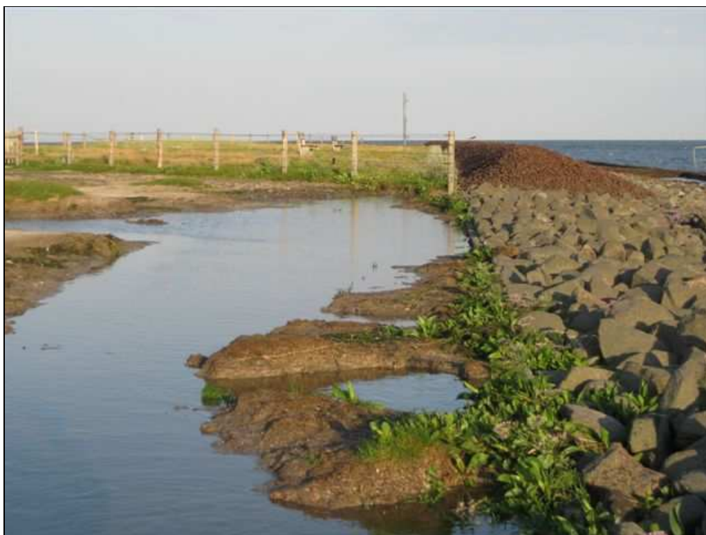
Foto 1: Auskolkungen hinter einem alten Deckwerk auf Gröde (Foto: Mommsen, 15.07.2010)
