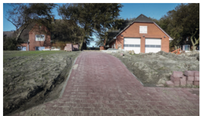
Die ersten Auffahrten sind gepflastert.
