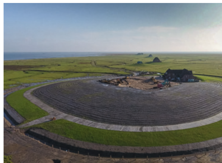
Die fertiggestellte Norderwarf
