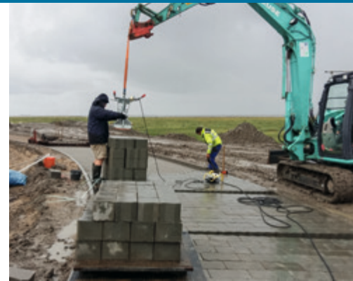
Setzen der Steine für den Treibselabfahweg
