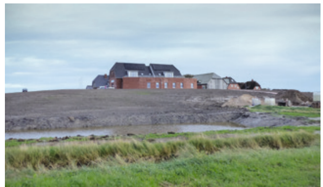
Die Abdeckung der Warf- oberfläche mit Klei ist fertig.
