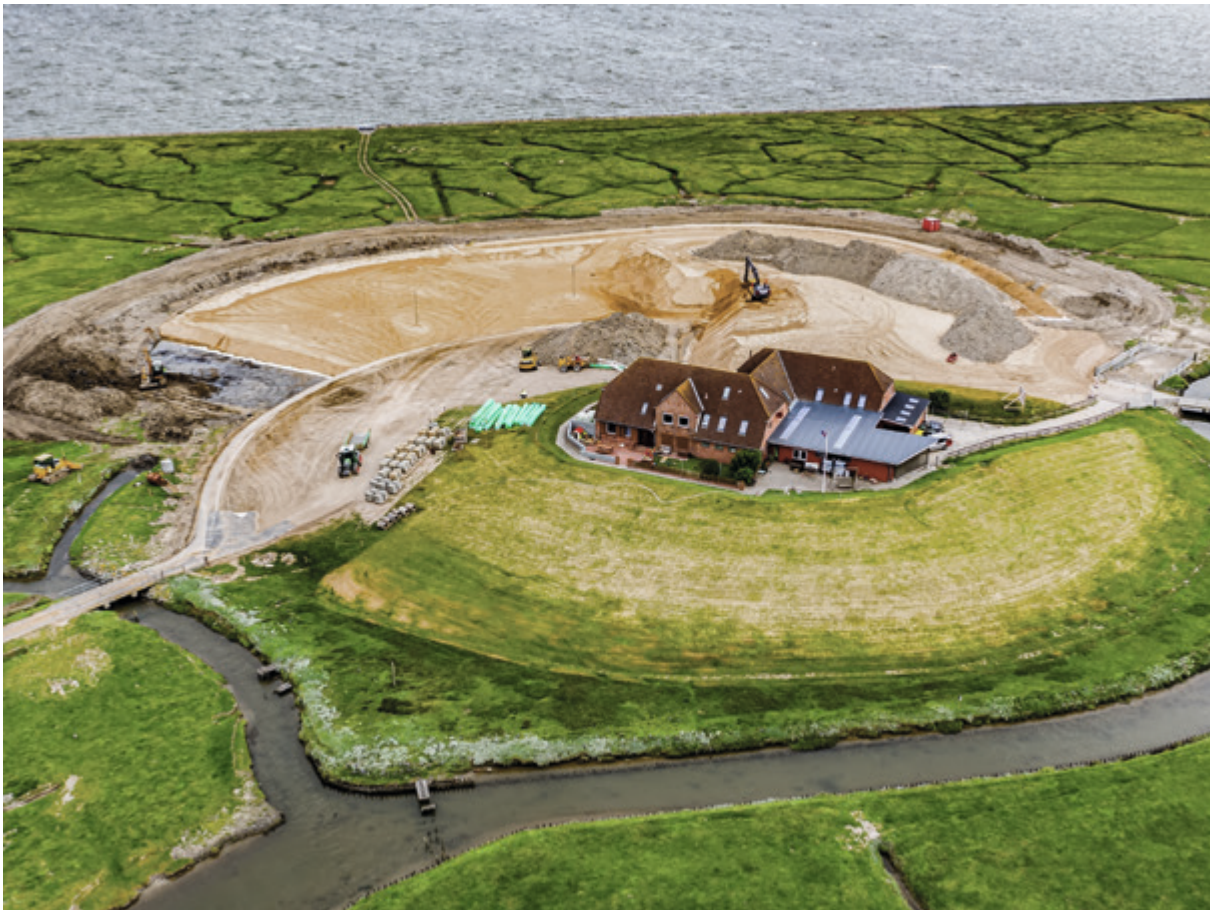
Blick von oben auf die Baustelle
