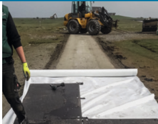
Schützende Befestigung der Straße
