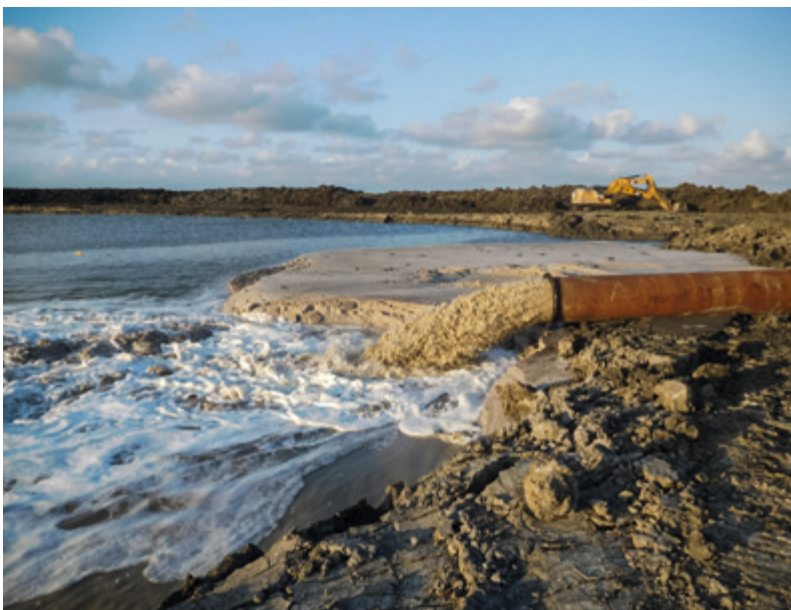
Sandspülung in den Ringdeich
