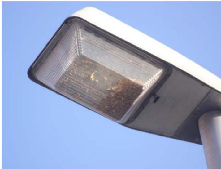
**Abb. 1.4:** In undichten Leuchtengehäusen sammeln sich die Insekten, die vom Licht angezogen werden.
